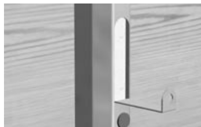
Окончание профиля загнуть под углом 90°
