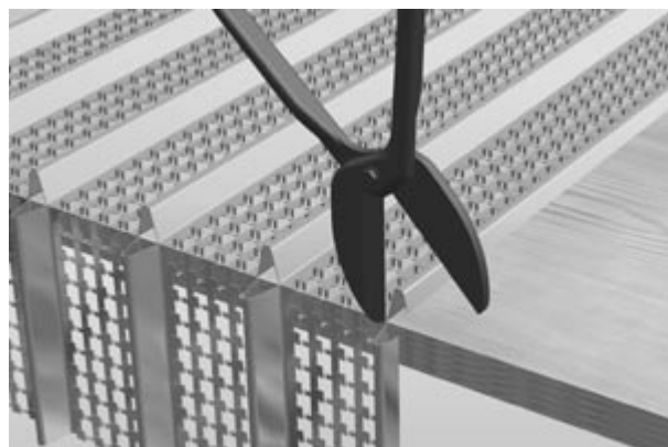
Надрезка оребрения при создании угольника
