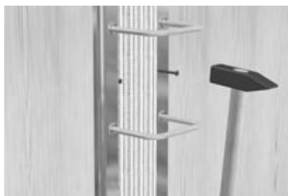
Прибить соединитель Dumbo-Stahl к опалубке двумя гвоздями через перфорацию.
